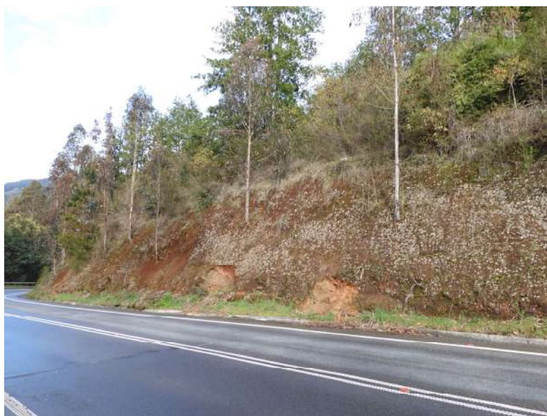
Ilustración 1-27 Ejemplo de deslizamientos menores camino a Huelleshue, ruta T-35.
